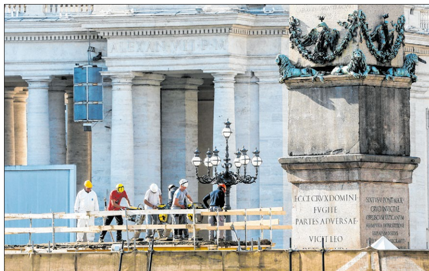
▲ Arbeiter befestigen Sand als Untergrund für eine Krippe auf dem Petersplatz. Künftig entscheiden im Vatikan Fachausschüsse über die Vergabe von Aufträgen. Foto: KNA
