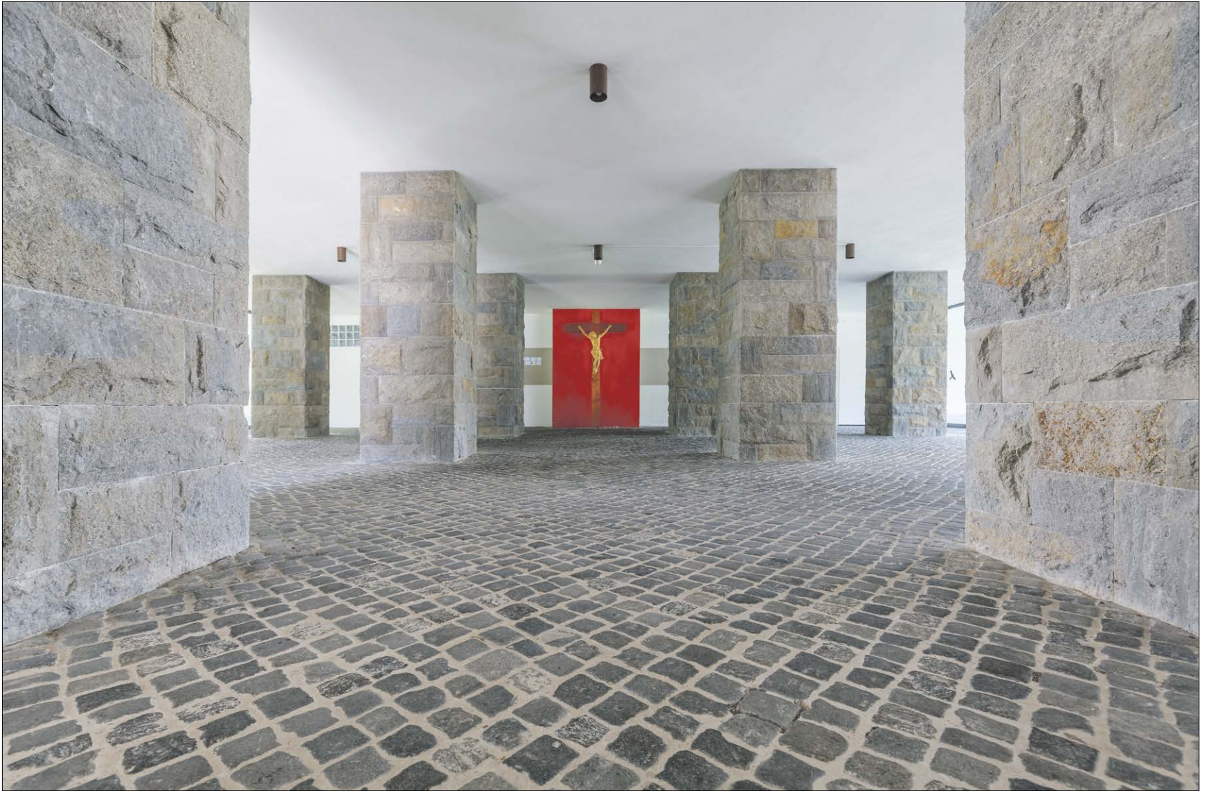
▲ Die Kirche Zwölf Apostel in Augsburg-Hochzoll besteht aus einer Unter- und einer Oberkirche. Die Oberkirche ruht auf zwölf Pfeilern – sinnbildlich für die zwölf Apostel als tragende Säulen der Kirche. Durch die vorgelagerte Säulenhalle gelangt man in die Unterkirche.
