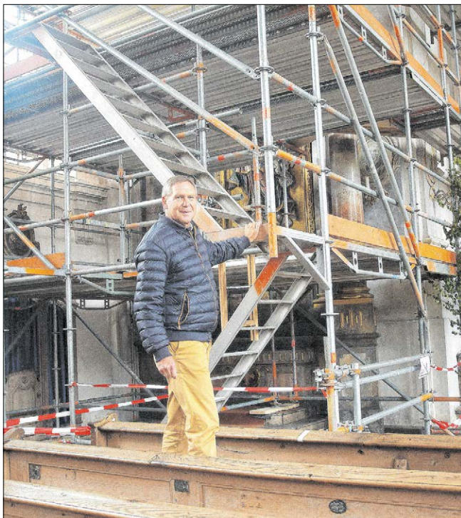
◀ Kirchenpfleger Gerald Kraus in der Pfarrkirche St. Stephan in Pfaffenhause. Mit Hilfe des Stahlgerüsts werden Voruntersuchungen für die Innenrenovierung vorgenommen.
