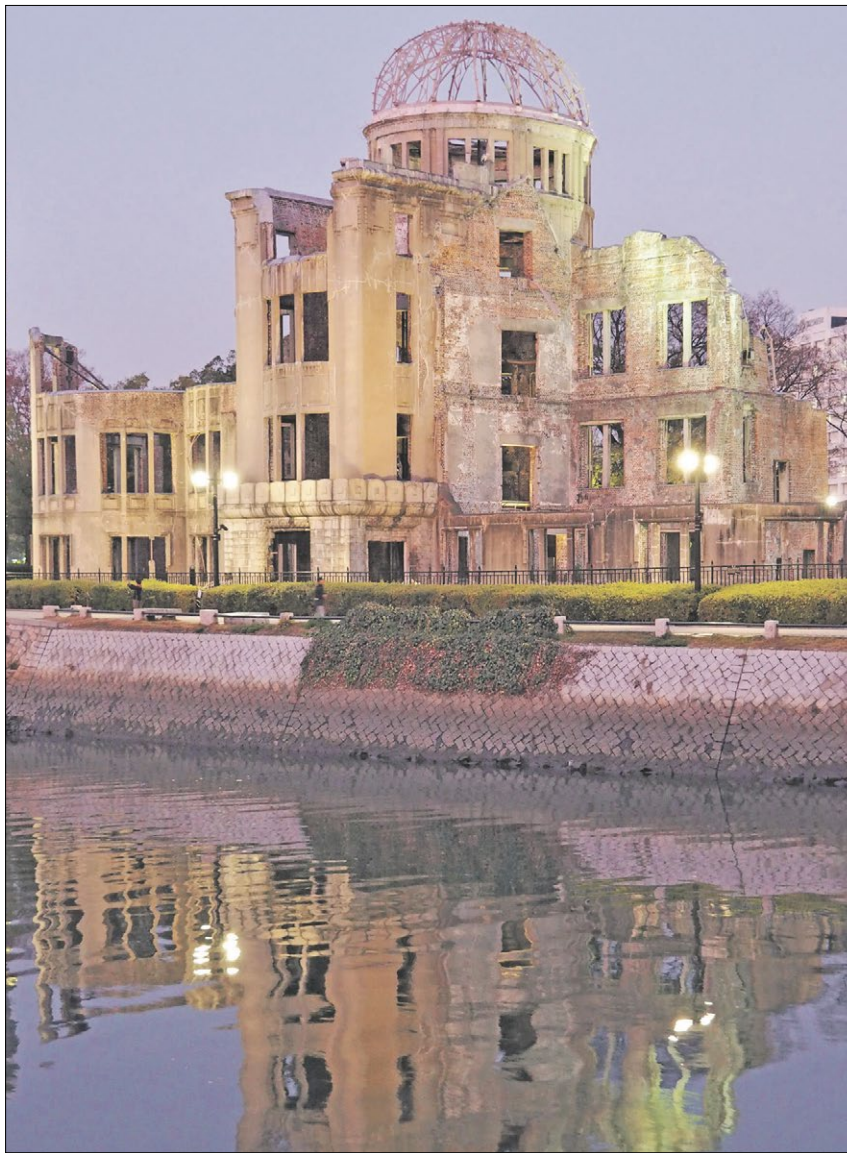
▲ Der „Atomic Bomb Dome“ war bis zum Abwurf die Ausstellungshalle der regionalen Industrie- und Handelskammer. Weil das Gebäude als eines der wenigen in Grundzügen erhalten blieb, ist es heute ein Symbol der Stadt.
