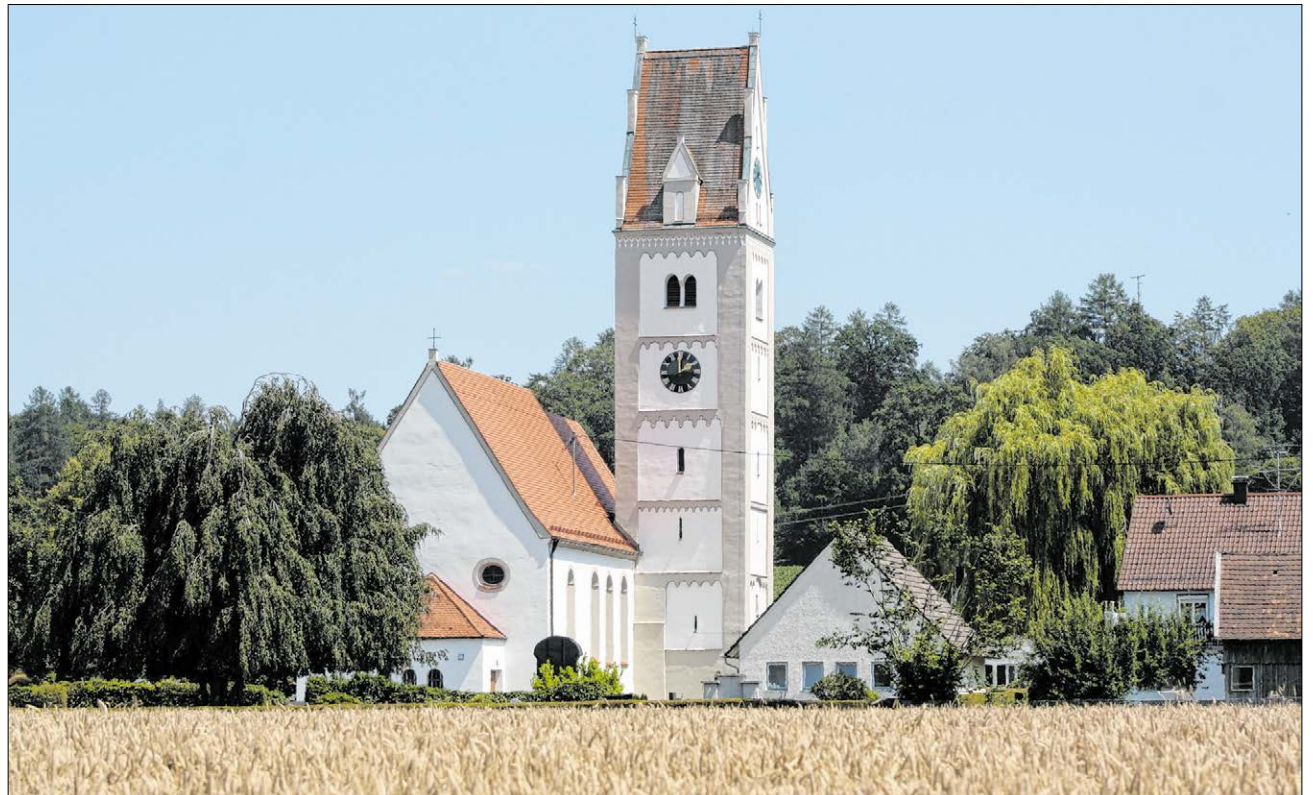
▲ In der eineinhalbjährigen Sanierungsphase wurde das Gotteshaus umfassend saniert.
