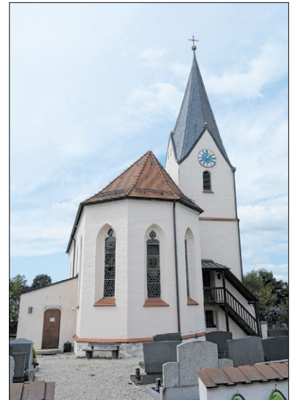
▲ Der Turm der Benefiziumskirche St. Peter in Bubach stammt vermutlich aus dem 12. oder 13. Jahrhundert. Foto: Mohr
