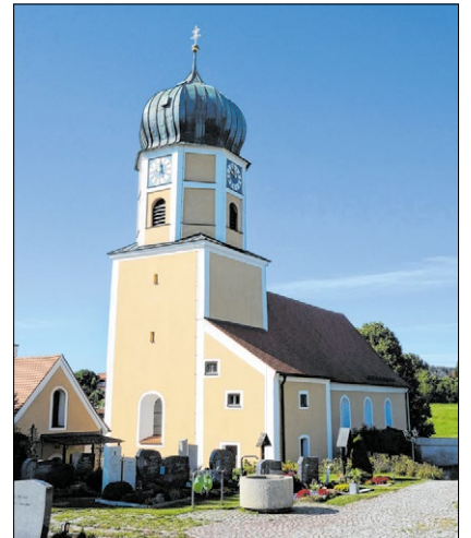
▲ Der Turm der Kirche St. Martin in See weist wohl noch frühromantisches Quadermauerwerk auf. Foto: Mohr
