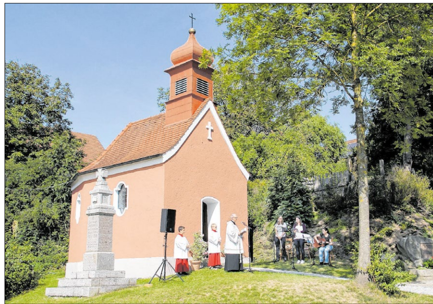
▲ Nach abgeschlossener Renovierung erhielt die Rottendorfer Kapelle den kirchlichen Segen. An exponierter Stelle ist sie eine echte Zierde für das Dorf und ein sehenswertes Kleinod. Foto: Böhm
