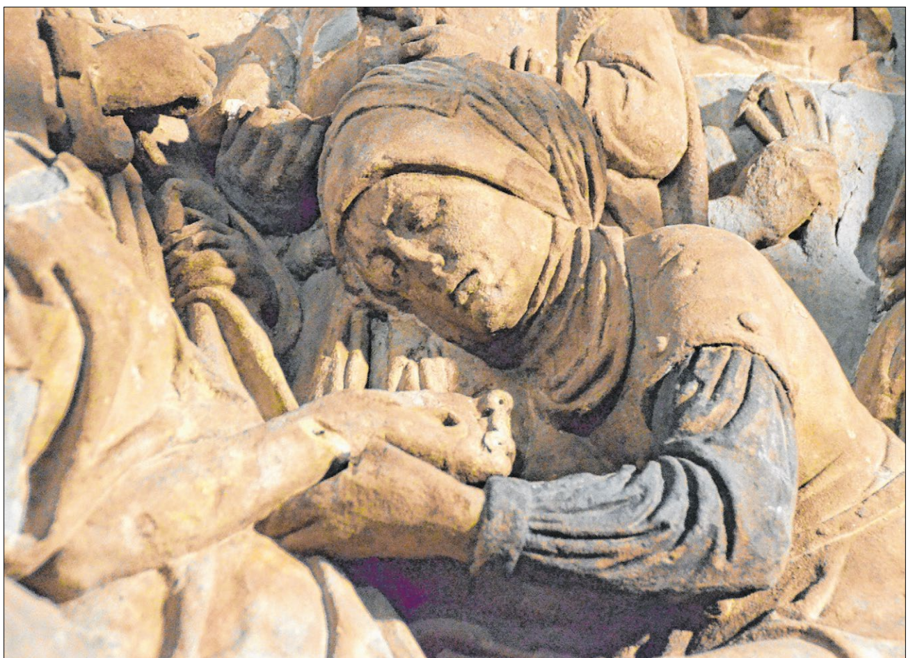
▲ Deutlich zu sehen ist der Unterschied zwischen den gereinigten und den nicht gereinigten Flächen.
