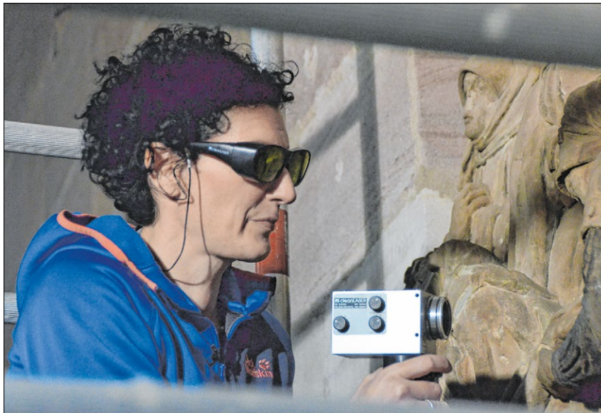
▲ Millimetergenau bearbeitet Restauratorin Katrin Müller mit dem Laser den Sandstein der Kreuzwegstationen. Fotos: Kuschbert
