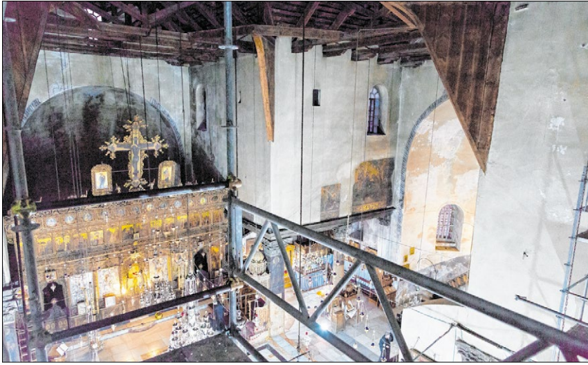
▲ Weil die Balken morsch waren, begann die umfassende Renovierung der Geburtskirche mit dem Dachstuhl. Fotos: KNA
