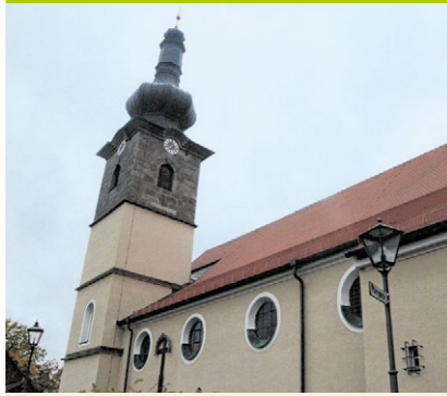
Mit viel Eigenleistung ist der erste Bauabschnitt, die Außenrenovierung der Pfarrkirche St. Matthäus in Wurzburg, vollendet worden.
