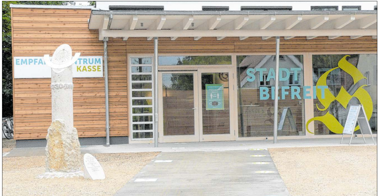
▲ Die Stadt Friedberg will das Empfangsgebäude der Landesausstellung auch künftig für Veranstaltungen nutzen. Fotos: Alt
