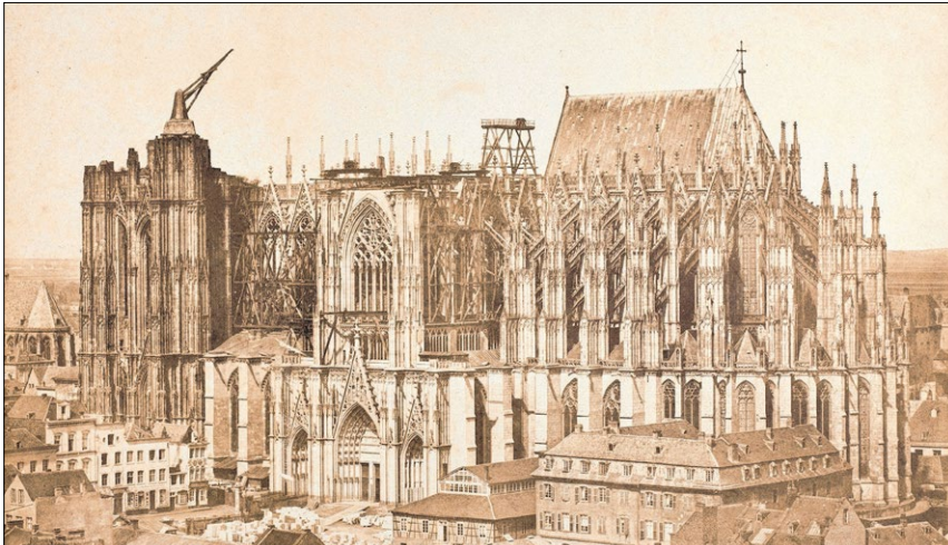
▲ Die Bauarbeiten schreiten voran: Der Kölner Dom um 1855.
