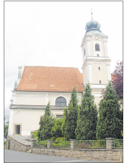
▲ Weithin sichtbar auf einer Anhöhe über dem Tal der Waldnaab bei Neustadt liegt die Wallfahrtskirche St. Felix. Foto: Mohr
