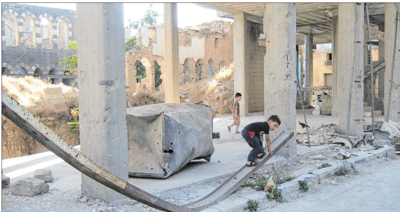
▲ Kinder spielen in den Ruinen im Stadtteil Wadi Sagher. Das Viertel ist noch stark zerstört.
