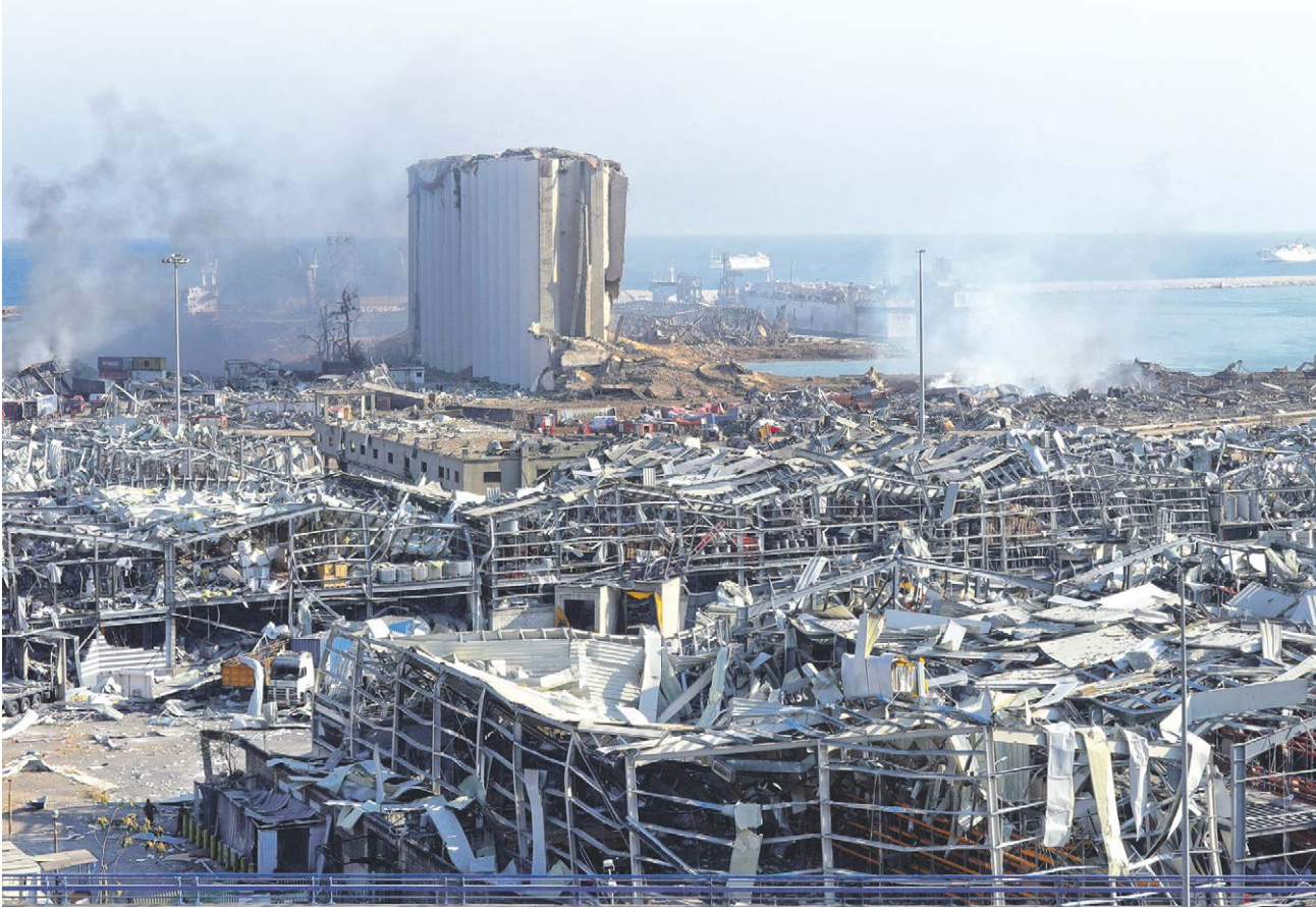
▲ Die Explosionen, die sich am 4. August 2020 um 18.08 Uhr ereigneten, verwandelten Teile des Beiruter Hafens in eine Kraterlandschaft und viele Gebäude in Ruinen. Auch weiter entfernte Häuser und Wohnungen wurden massiv zerstört. Mehr als 200 Menschen starben, über 6500 wurden verletzt, Zigtausende verloren ihre Wohnung. Foto: imago images/UPI
