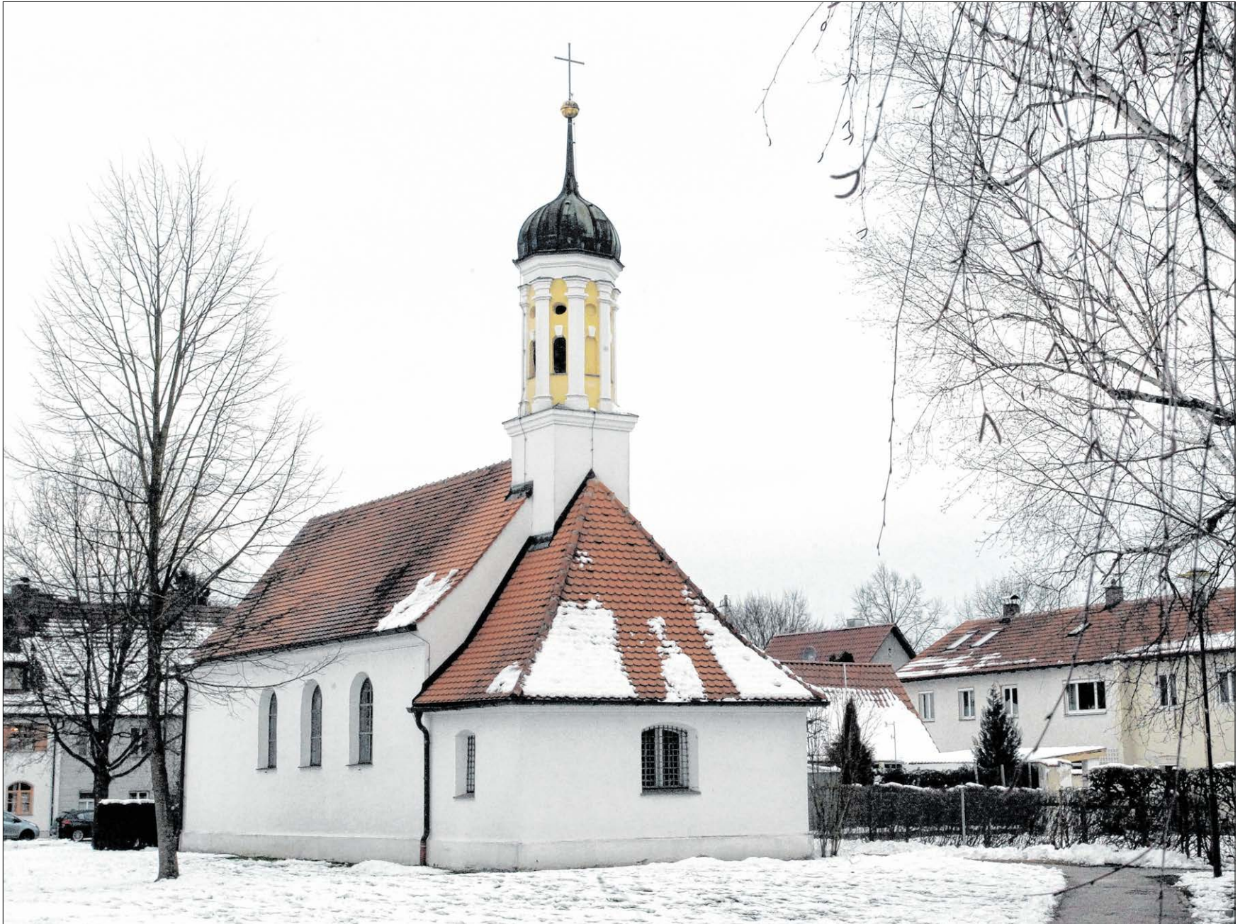
▲ Die Kapelle St. Ägidius in Neusäß befindet sich neben der gleichnamigen Pfarrkirche und gehörte ursprünglich zum Remboldschlösschen. Sie stammt aus dem 16. Jahrhundert und wurde 1711 umgebaut und neu ausgestattet. Um die Kapelle wurde ein kleiner Park mit Teich angelegt, der Ägidiuspark. Kirche und Kapelle sind dem heiligen Ägidius von St. Gilles geweiht und beide geschützte Baudenkmäler. Foto: Zoepf
