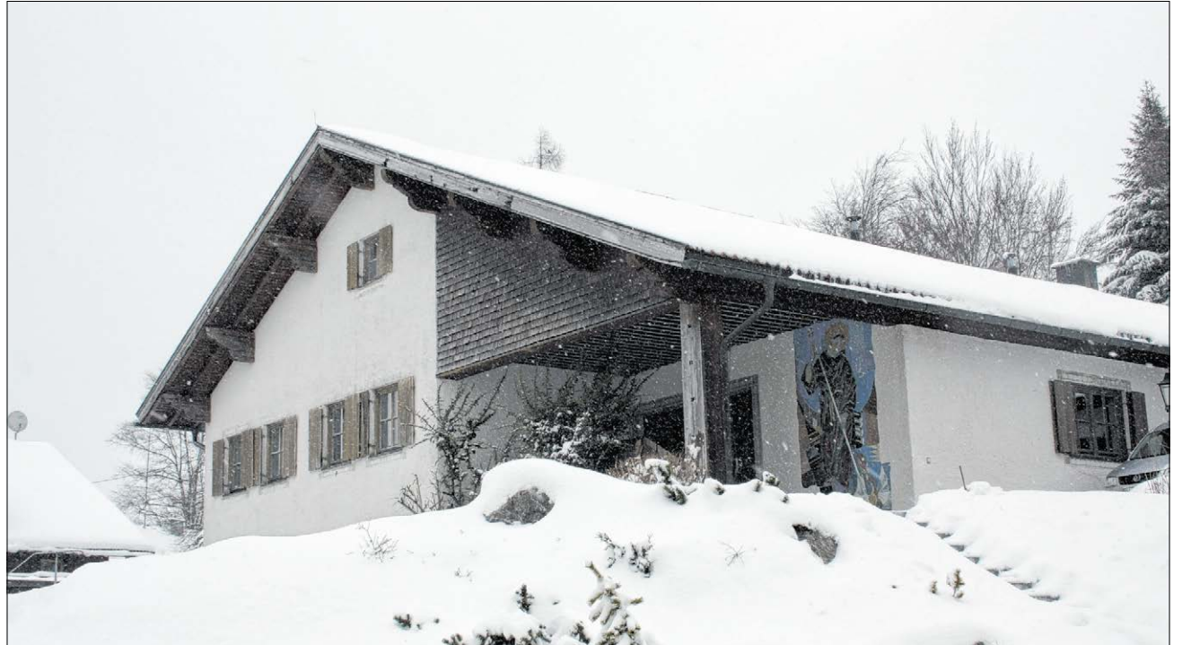
▲ Das renovierte Pfarrheim St. Magnus in Buchenberg wurde 1972 errichtet.
