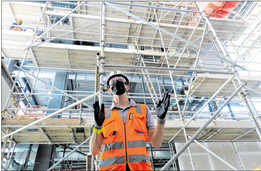
▲ Projektleiter Mirco Amstad auf der Baustelle des Deutschen Pavillons.
