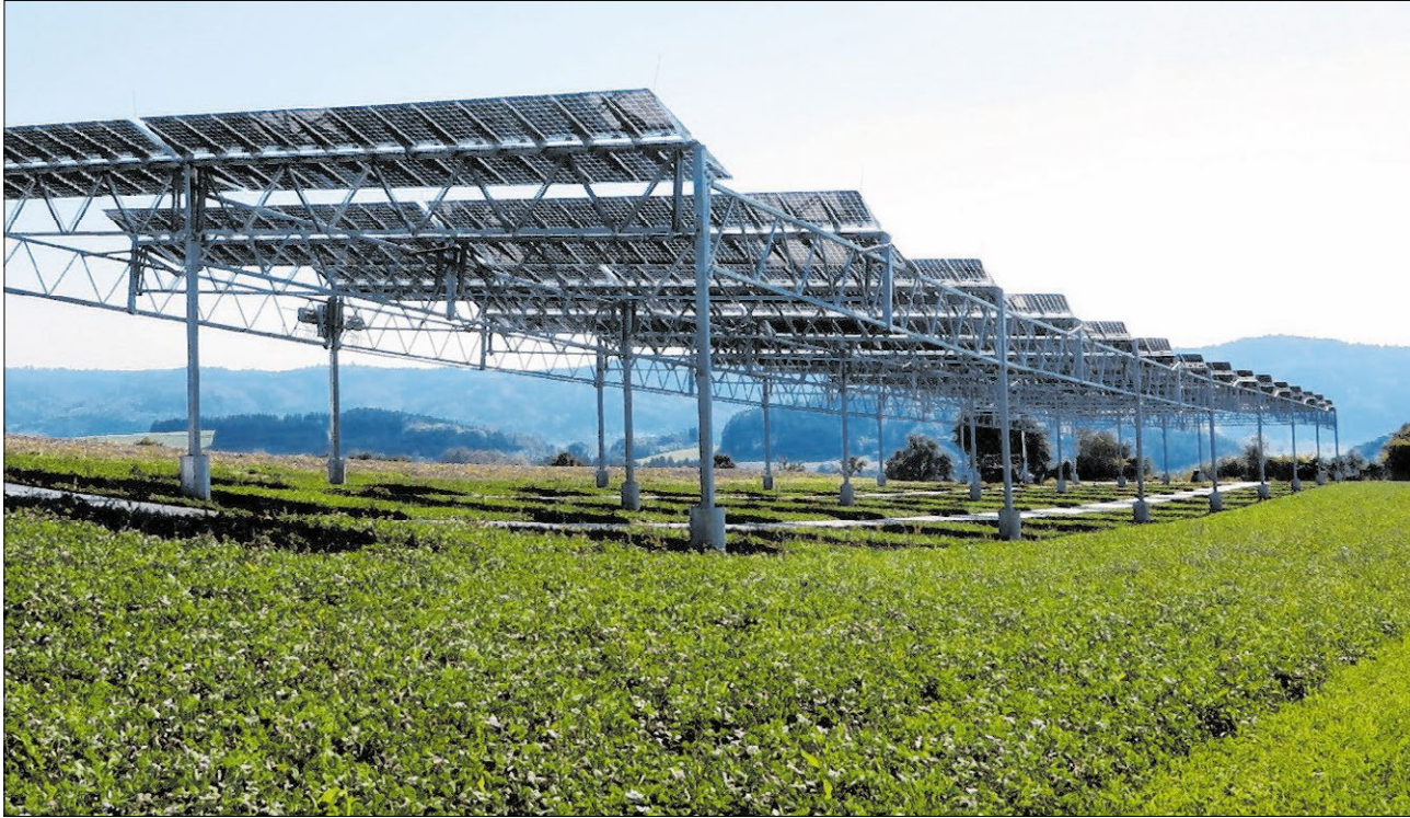
▲ Mit Agri-Photovoltaik-Anlagen sollen landwirtschaftliche Flächen in Zukunft doppelt genutzt werden – wie hier in Heggelbach, wo eine Pilotanlage betrieben wird. Foto: © Fraunhofer ISE
