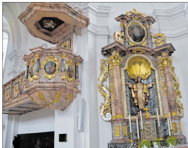
◀ Auch die Kanzel und der rechte Seitenaltar wurden einer gründlichen Renovierung vor Ort unterzogen.
