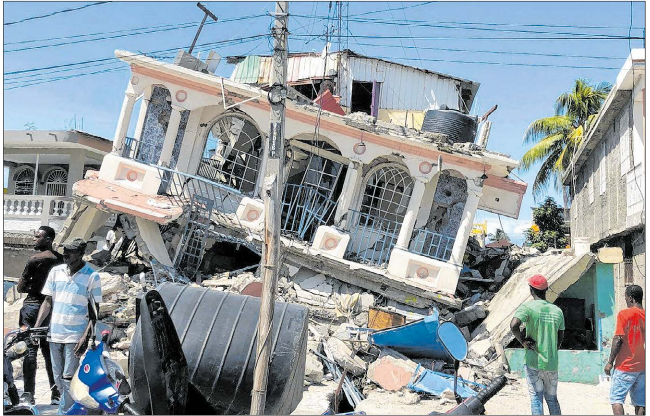
▲ Zerstörung, wohin man blickt: In der Hafenstadt Les Cayes brachte das Beben zahlreiche Gebäude zum Einsturz.
