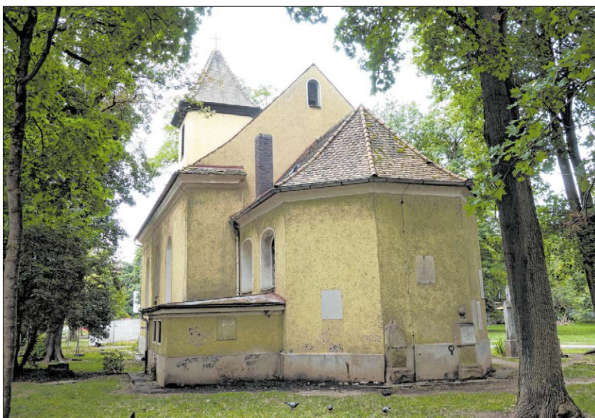
▲ Ost-Ansicht des Peterskirchleins.
