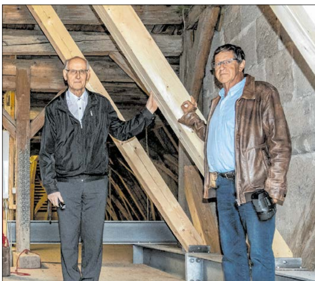
◀ Monsignore Paul Sinz und Kirchenpfleger Georg Brenner (von links) freuen sich, dass die Konstruktion, die den Dachstuhl „schwingungstechnisch“ vom Turm abkoppelt, kostengünstiger war als erwartet.
