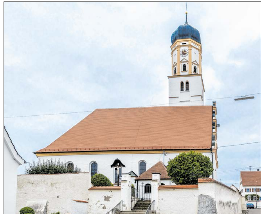
▲ Die Dachstuhl- und Außensanierung der Pfarrkirche Mariä Reinigung in Steinheim ist abgeschlossen. Fotos: Bunk
