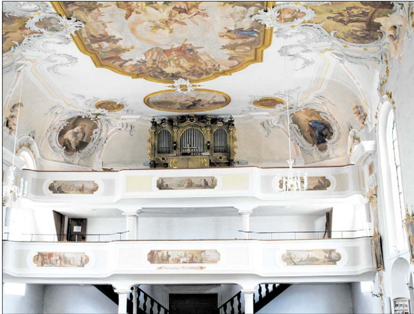
▲ Verschönerungsarbeiten an der Stuckdecke wurden nicht mehr eingeplant. Alle übrigen Reparaturen wurden jedoch fachmännisch vorgenommen.
