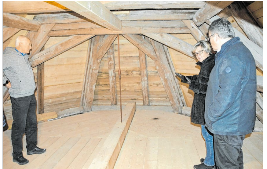
▲ Zufrieden mit den Arbeiten zeigten sich (von links): Kirchenpfleger Robert Biersack, Architektin Helga Rembeck und Pfarrer Pater Adrian Kugler O.Praem. Foto: M. Bauer
