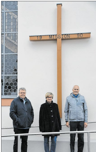
▲ Auch das an die Gemeindemission 1990 erinnernde Kreuz wurde renoviert. Im Vordergrund (von links) Pfarrer Pater Adrian Kugler, Architektin Helga Rembeck und Kirchenpfleger Robert Biersack. Foto: M. Bauer
