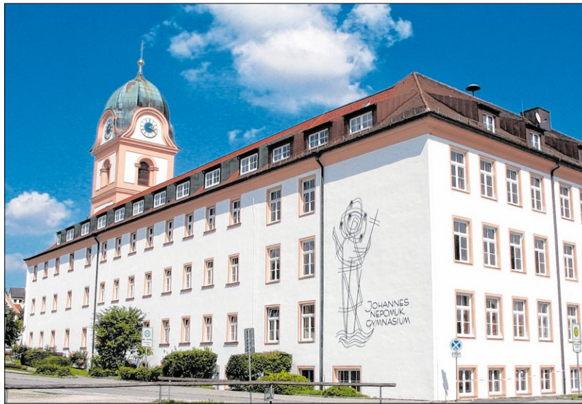
▲ Das Johannes-Nepomuk-Gymnasium in Rohr.
