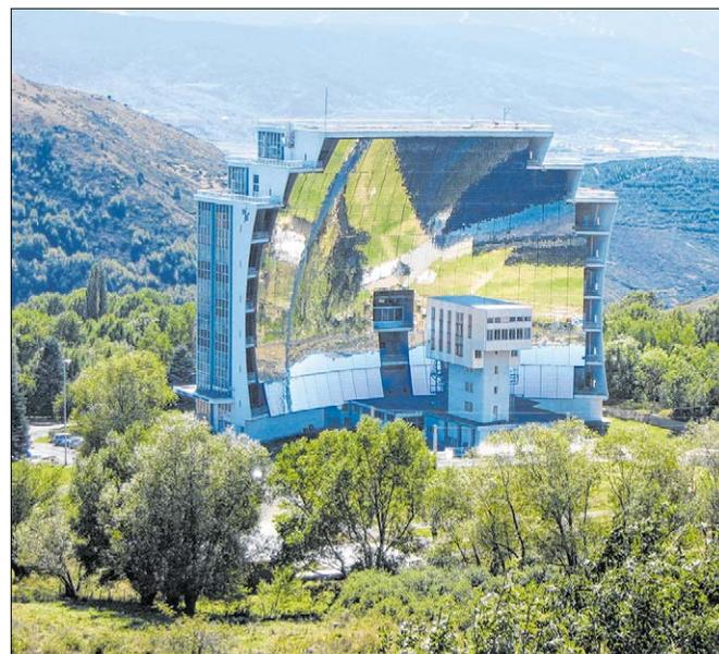
Der Sonnenofen von Odeillo. Der Punkt, an dem das Licht gebündelt wird, kann auf über 3000 Grad erhitzt werden. Die Anlage ermöglicht es Forschern, Proben auf extreme Temperaturen zu erhitzen, ohne Schadstoffe zu erzeugen.
