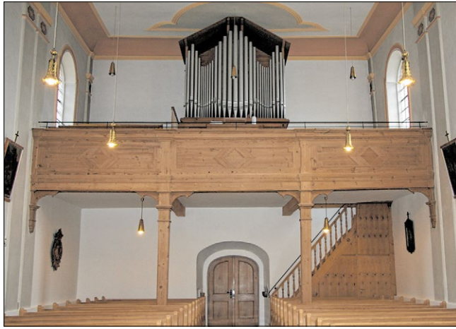
◀ Die Empore wurde nach außen unsichtbar verstärkt.
