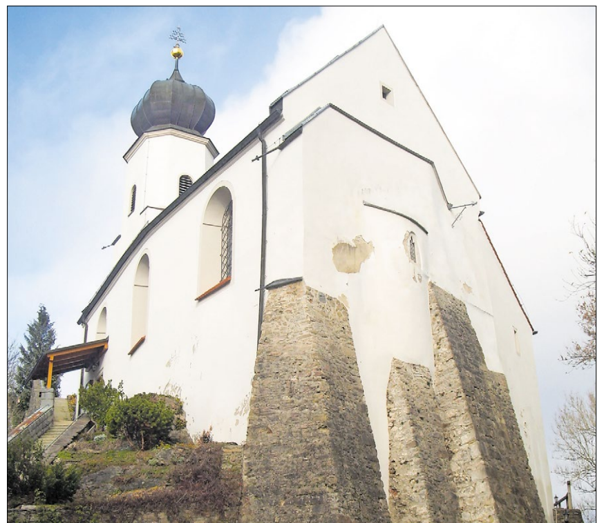
▲ Die Wallfahrtskirche St. Ulrich auf dem 636 Meter hohen Ulrichsberg. Foto: Mohr
