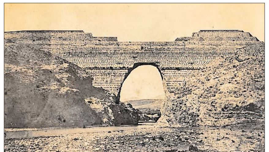
▲ Infolge starker Regenfälle entstand ein großes Loch in der Talsperre von Puentes. Sie sah dadurch wie eine Brücke aus. Ursache war ein Baufehler.
