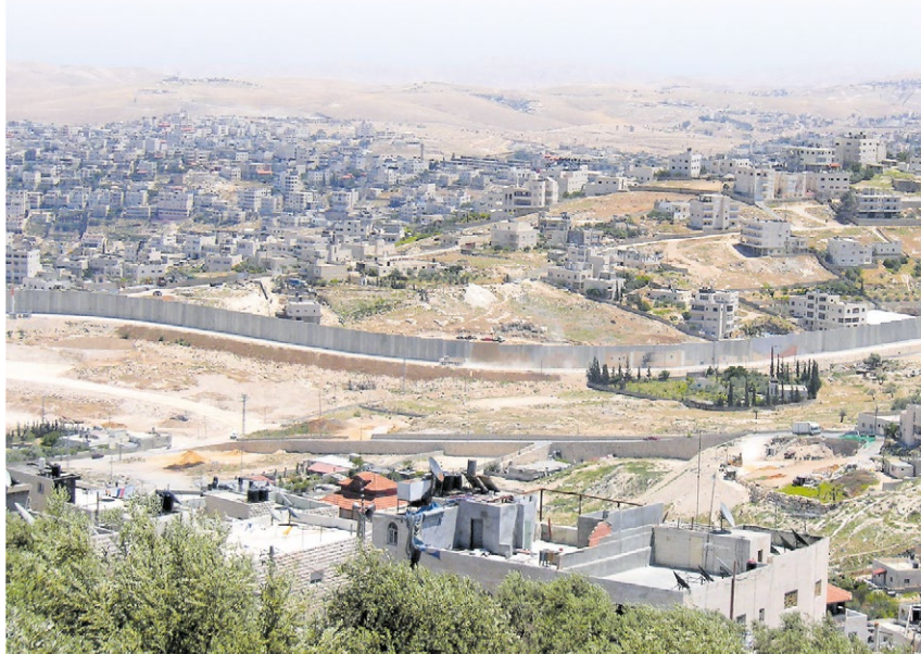
▲ Israels Sperrmauer – hier ein Blick vom Ölberg – durchschneidet Palästina.
