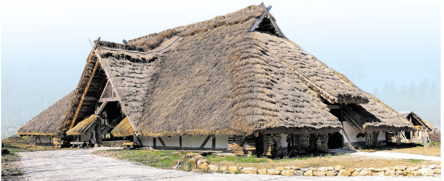
▲ Die mehr als 20 Meter lange Scheune ist das bislang größte vollendete Gebäude der „Karolingischen Klosterstadt“ bei Meßkirch. Wie alle Gebäude des Projekts wurde es mit Materialien und Technik des frühen Mittelalters errichtet. Fotos: Thiede
