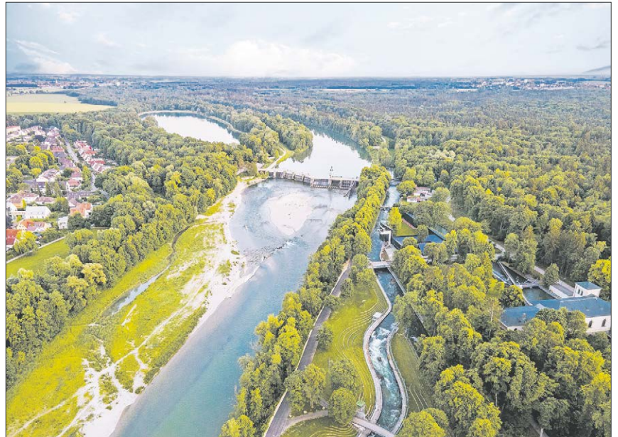
▲ Im östlichen Stadtgebiet von Augsburg liegen das Stauwehr „Hochablass“ und die Kanuslalomstrecke am Lechradweg. Beides gehört zum Unesco-Welterbe des Wassermanagement-Systems. Fotos: Regio/Martin Augsburger
