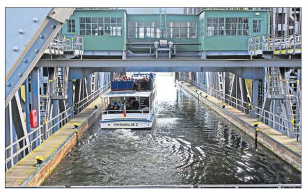
▲ Ein Schiff überbrückt im alten Hebewerk die 36 Meter Höhenunterschied auf dem Oder-Havel-Kanal.
