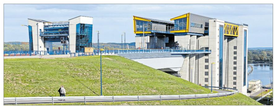
▲ Das Sicherheitstor links wird geschlossen, wenn das Hebewerk gewartet werden muss oder es zu einer Havarie kommt. Sonst würde der Kanal leerlaufen.
