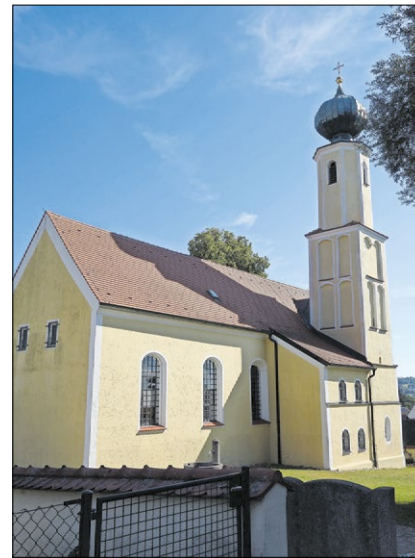
▲ Die Pfarrkirche St. Peter in Appersdorf. Foto: Mohr
