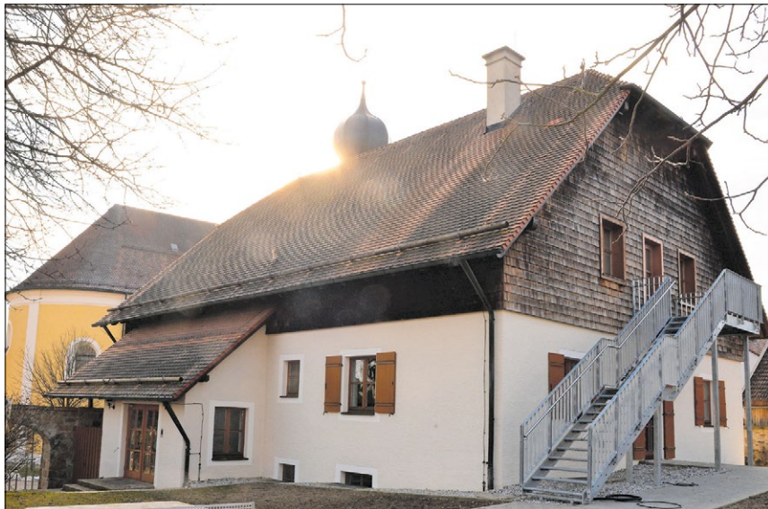
▲ In direkter Nachbarschaft zur Pfarrkirche steht das neu gestaltete Pfarr- und Jugendheim. An der Nordseite ist die neue Fluchttreppe angebaut. Foto: Hilmer
