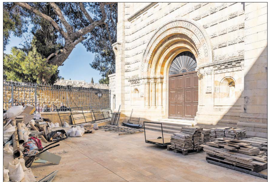
▲ Die Baustelle vor und in der Kirche sowie in der Abtei wurde vielfach verzögert.
