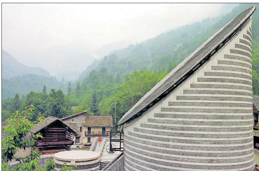
▲ Die „steinernen Himmelsleiter“ der Botta-Kirche San Giovanni Battista (Heiliger Johannes der Täufer) in Mogno im schweizerischen Kanton Tessin. Bei der Planung des Kirchbaus gab es Streitigkeiten – bis zum Machtwort des Bischofs zugunsten des Architekten. Spötter nennen den Bau „überdimensionale Bischofsmütze“. Fotos: KNA
