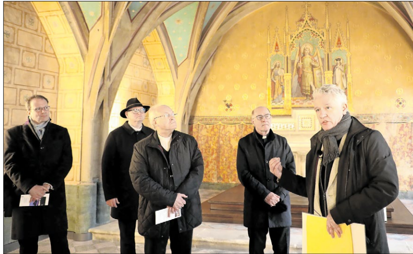
▲ Der Leiter des Staatlichen Bauamtes Regensburg Karl Stock (rechts) erläuterte die Arbeiten am sanierten Domkreuzgang. Foto: Schötz
