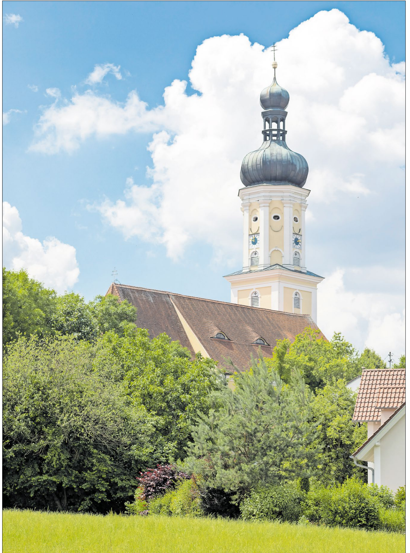
▲ Die Pfarrkirche St. Magnus in Kühbach wurde als Klosterkirche des ehemaligen Klosters St. Magnus um das Jahr 1000 erbaut. Das massive Untergeschoss des Turms mit dem Rundbogenfries stammt noch aus dieser Zeit. Nach einem Brand 1577 wurde die Kirche im gotischen Stil errichtet. Die heutige Barockkirche wurde 1687 bis 1688 erbaut, wobei Teile des Vorgängerbaus verwendet wurden. Das Kloster wurde nach einem verheerenden Brand im Jahre 1860 im klassizistischen Stil wieder aufgebaut und ist heute als Schloss Kühbach in Privatbesitz. Foto: Banner
