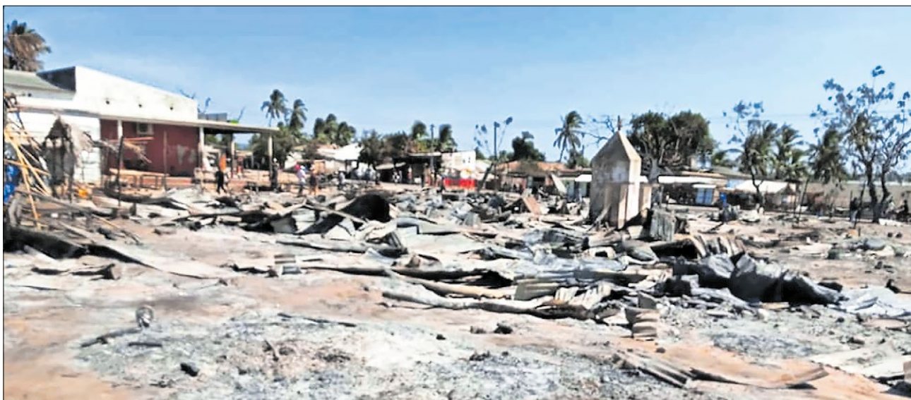
▲ Von islamistischen Terroristen zerstörte Häuser in der Diözese Pemba im unruhigen Norden Mosambiks.
