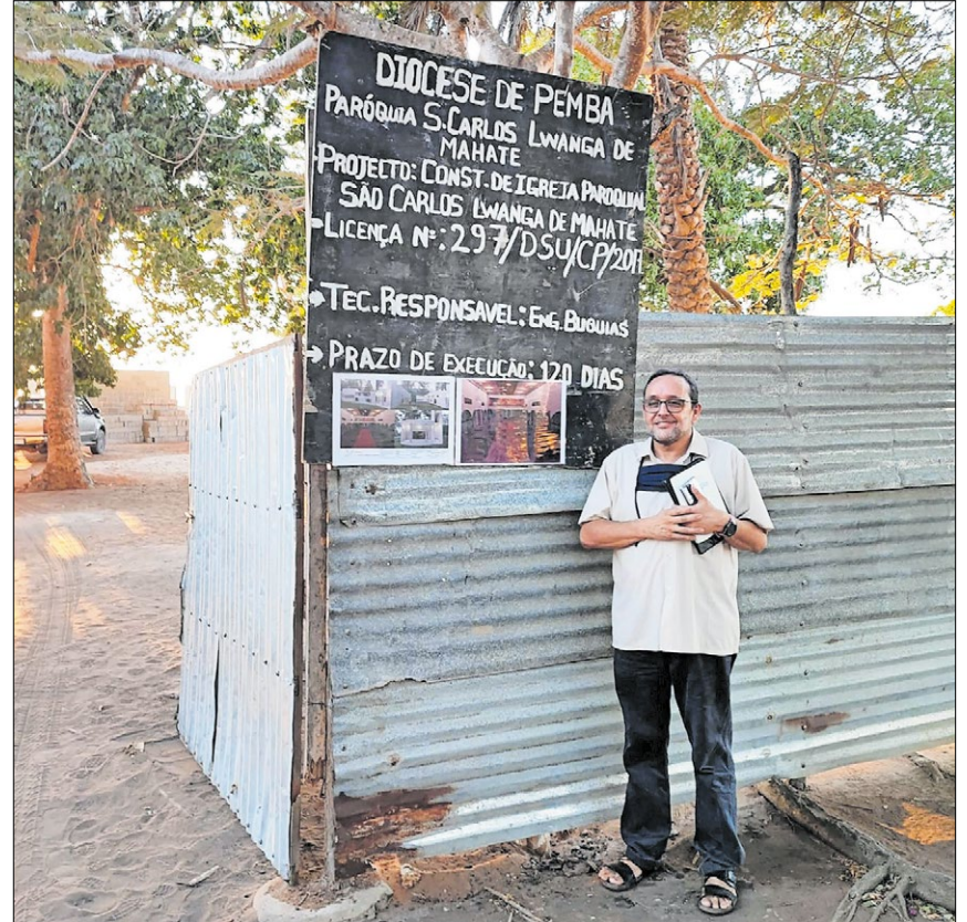
▲ Eduardo Andrés Roca Oliver, Leiter des interreligiösen Zentrums in Pemba, vor der Baustelle der Kirche „St. Karl Lwanga“. Fotos: Kirche in Not
