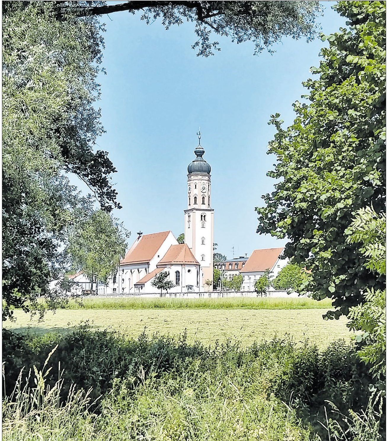
▲ Blick auf die Pfarrkirche St. Martin in Horgau. Das Erscheinungsbild der 1735 geweihten Kirche geht im Wesentlichen auf die Bautätigkeit im 17. und 18. Jahrhundert zurück, wobei der Chor noch aus dem 15. Jahrhundert stammt. Der 46 Meter hohe Turm mit quadratischem Unterbau und oktagonalem Aufbau hat eine doppelte Zwiebelhaube. Im Inneren verfügt die Kirche über eine reiche Ausstattung mit Stuck und Fresken.
