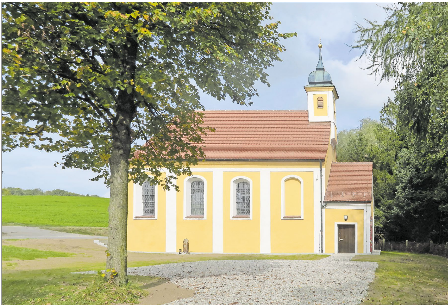
▲ Die frisch renovierte Wallfahrtskapelle Unserer Lieben Frau ob der Au liegt bei Obergriesbach, direkt an der Straße von Dasing nach Sulzbach. Die Wallfahrt geht zurück auf ein angebliches Wunder Ende des 17. Jahrhunderts: So soll ein Bild mit einer Darstellung Mariens geblutet haben, das zuvor von einem schwedischen Soldaten beschädigt worden war. Kurze Zeit später wurde zunächst eine Holzkapelle errichtet, die 1714 durch einen gemauerten Bau ersetzt wurde. 1737 ließ Graf Max Emmanuel von Thurn und Taxis die Kapelle erhöhen und erweitern. Zudem wurde ein neuer Altar beschafft, in den das beschädigte Marienbild integriert wurde. Die Szene der Verunstaltung des Bildes ist im Deckenfresko dargestellt.
