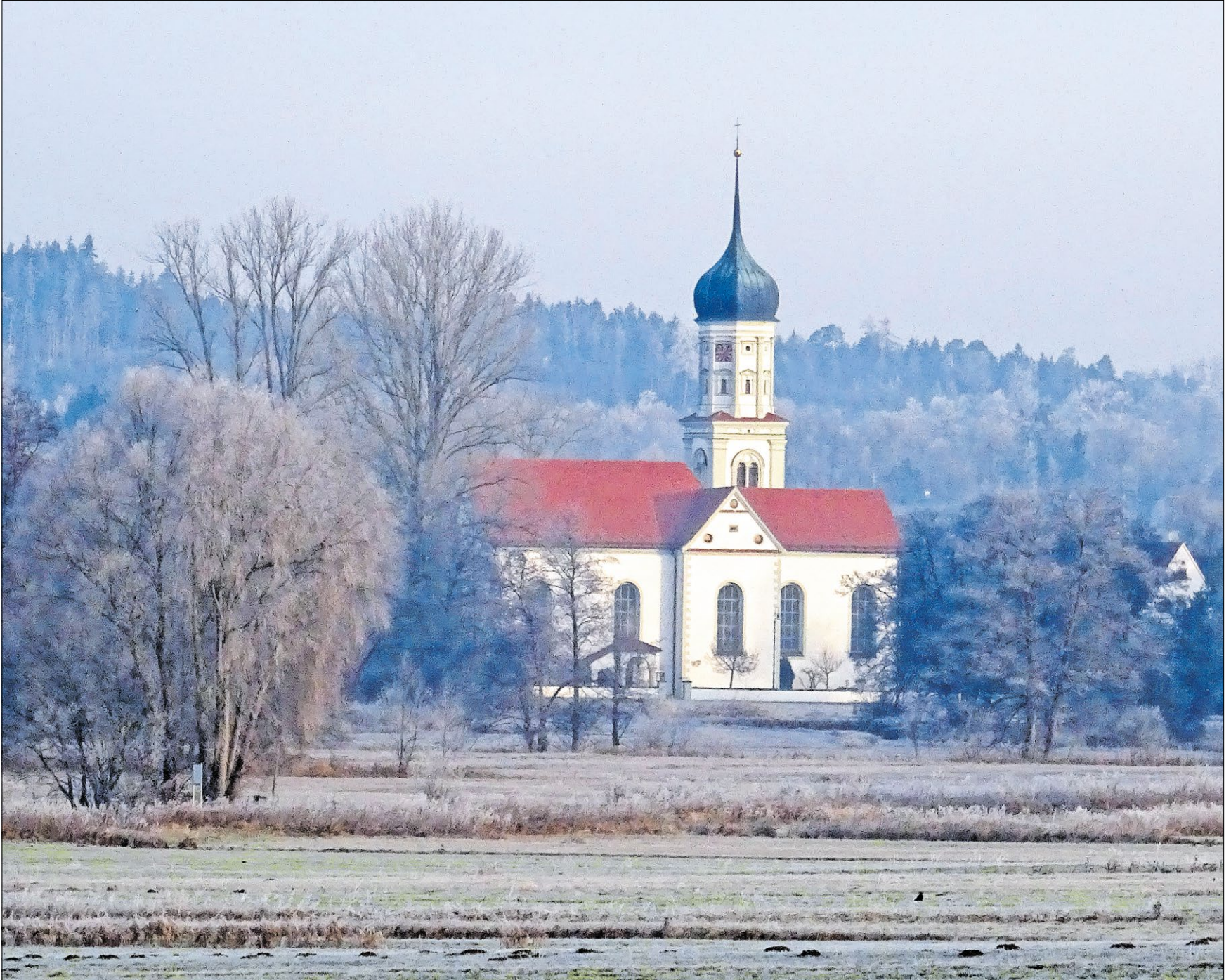
▲ Am westlichen Ortsrand von Gessertshausen zwischen Staudenbahn und Schmutter liegt der Weiler Dietkirch mit seiner Pfarrkirche St. Johannes Baptist. Die beiden untersten quadratischen Turmgewölbe stammen noch von einer romanischen Chorturmkirche. In der Barockzeit wurde der Kirchturm mit einem stark gegliederten Oktogon erhöht und mit einer Zwiebelhaube bekrönt. Im Auftrag des Klosters Oberschönenfeld wurde 1723 der Grundstein für eine vollkommen neue Kirche gelegt, wobei der Turm des alten Bauwerks in den Neubau mit einbezogen wurde. Das Gotteshaus gilt als letzter Bau des bekannten Baumeisters Franz Beer II aus Vorarlberg. Foto: Krünes
