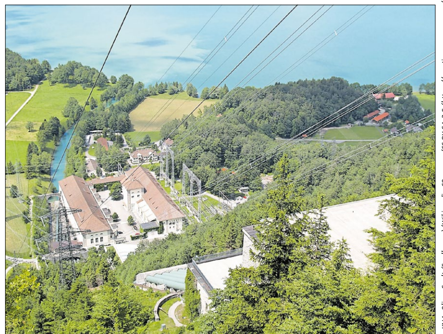
▲ Das Walchenseekraftwerk im oberbayerischen Altjoch bei Kochel am See. Vom Wasserschloss aus ist das Turbinenhaus und das Schalthaus zu sehen, hinten der Kochelsee.
