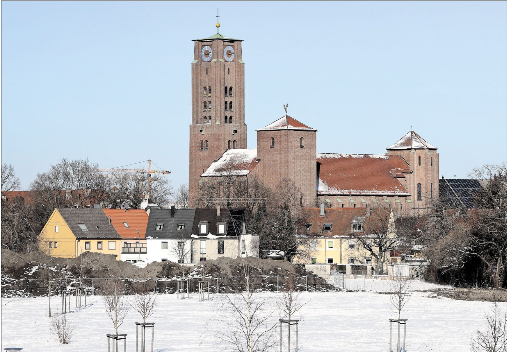
▲ Blick vom Wohngebiet Sheridanpark auf die Kirche St. Thaddäus im Augsburger Stadtteil Kriegshaber. Mit deren Bau wurde 1939 begonnen; 1948 wurde sie geweiht. In den folgenden Jahren wurde die Orgel und das Taufbecken eingebaut, die Turmkapelle, der Glockenturm sowie der Kreuzweg fertiggestellt und die Innenausstattung vollendet. Die schwierigen äußeren Umstände der Nachkriegszeit spiegeln sich in der zurückhaltenden Gestaltung der Kirche wider. Der Architekt Thomas Wechs setzte auf wirksame äußere Formen. Mit seinem 1981 vollendeten siebenteiligen Glasfensterzyklus verlieh Professor Georg Bernhard der Apsis der St.-Thaddäus-Kirche eine starke künstlerische Aufwertung. Foto: Zoepf
