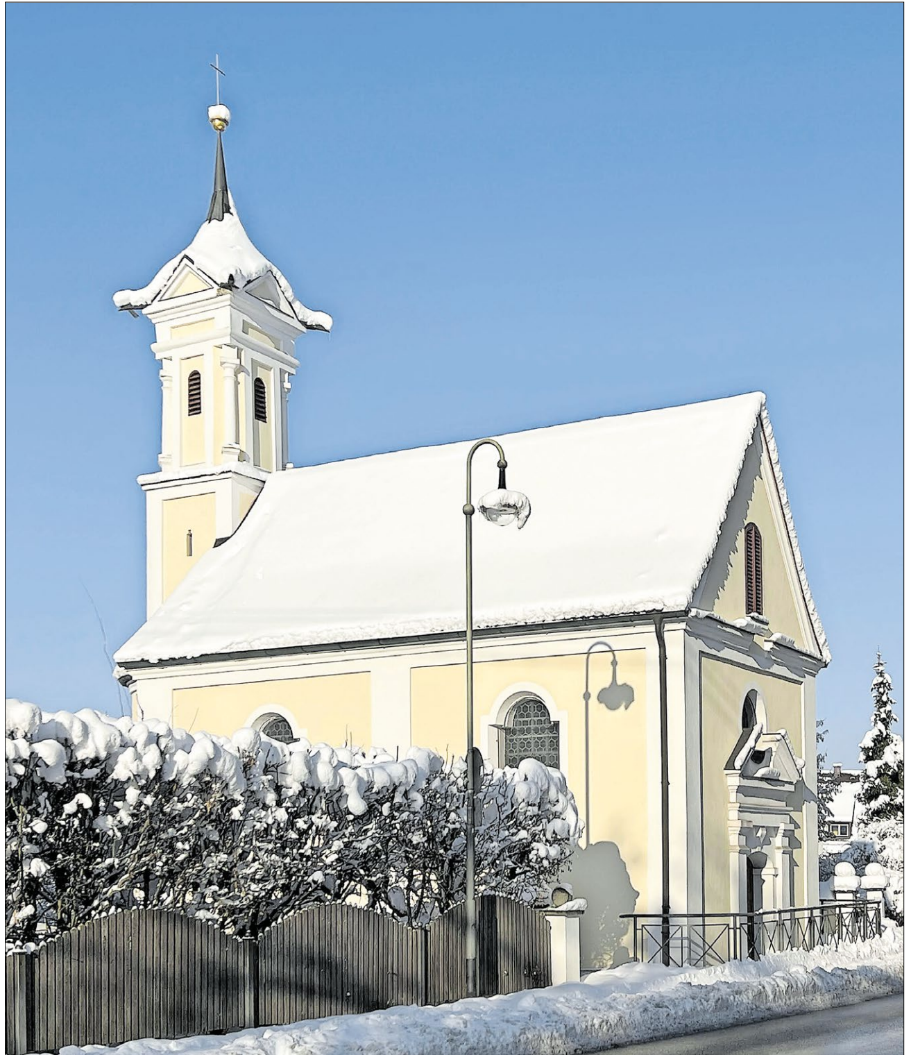
▲ Die dem Erzengel Michael geweihte Kapelle in Affing befindet sich am Schloßplatz nördlich der Pfarrkirche St. Peter und Paul. Der einschiffige Bau wurde 1698 errichtet. Er wird von einem Tonnengewölbe mit Stichkappen gedeckt. Über dem halbrunden Schluss befindet sich ein quadratischer Turm mit einer spitz auslaufenden Haube. Auf dem Deckengemälde im Innenraum ist Michael dargestellt, wie er Luzifer stürzt. Foto: Reinhaller
