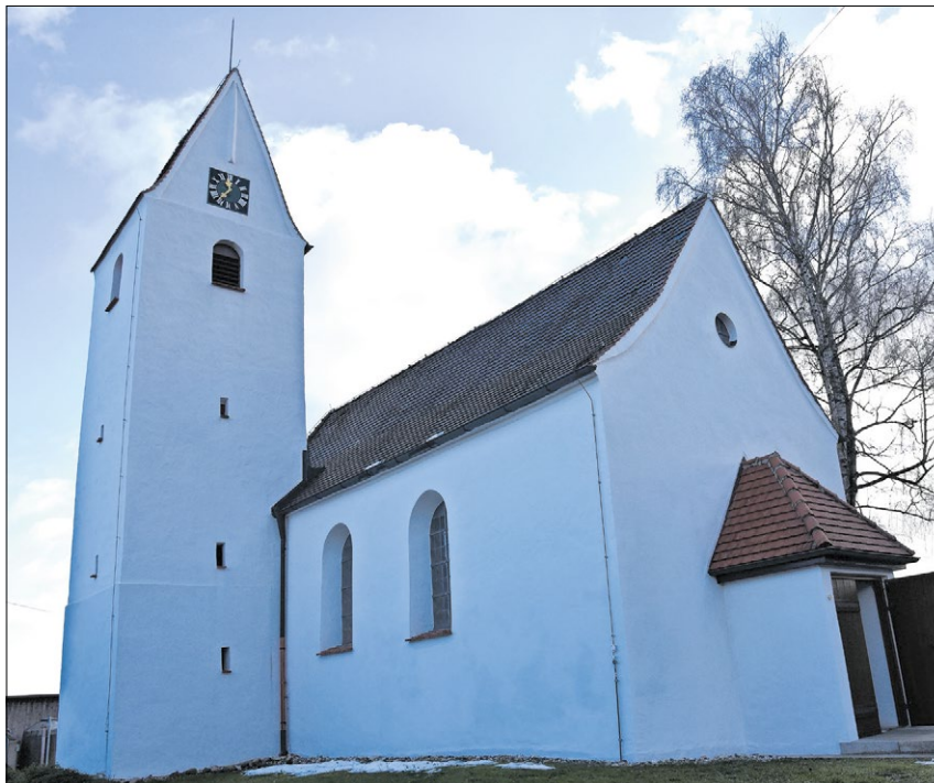
▲ Die Renovierungsarbeiten an der Bergenstetter Kirche sind beendet. Nachdem die Westseite 2022 durch Hagelschlag beschädigt wurde, bekam die ganze Außenfassade einen frischen Anstrich.
