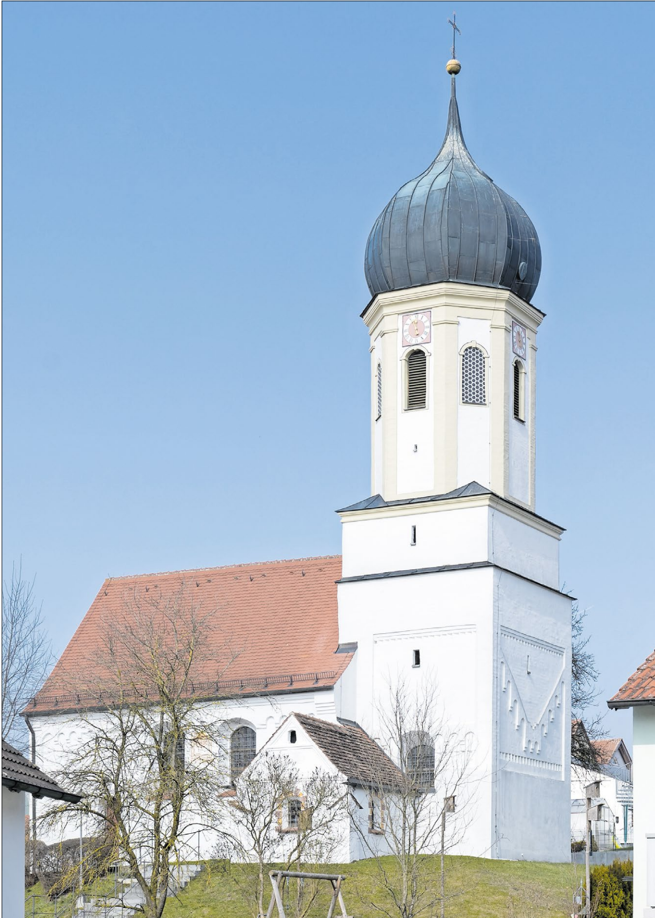
▲ Die Filialkirche St. Stephan und Magdalena in Tegernbach, einem Ortsteil von Mittelstetten, geht zurück auf eine romanische Chorturmanlage aus dem 12. Jahrhundert. Das barocke Turmobergeschoss mit Zwiebelhaube stammt aus einem Umbau im Jahr 1774. Während des Zweiten Weltkriegs mussten die Tegernbacher die größere der beiden Kirchenglocken abgeben. Überraschenderweise wurde sie jedoch nicht eingeschmolzen, sondern kehrte nach dem Krieg wieder zurück. Foto: Banner
