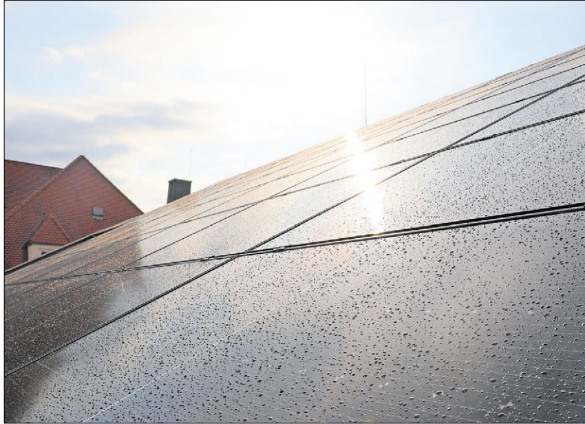
▲ Solarenergie wird aus der Kraft der Sonne gewonnen. Ist die Anlage einmal installiert, erzeugt sie Strom ohne Emissionen. Foto: Beitler
