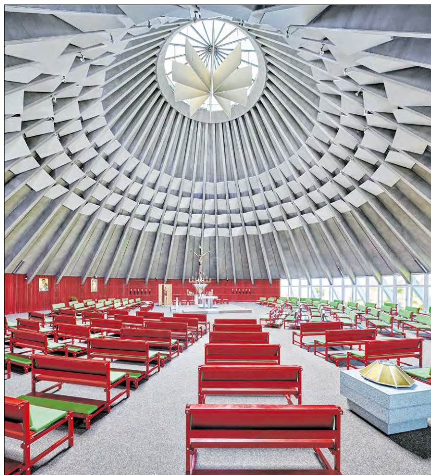
▲ St. Wolfgang in Syrgenstein (1970) besitzt einen runden Kirchenraum. Er wird durch Stahlbetonstreben gebildet, die oben als Dach zusammentreffen. Foto: Wameser
