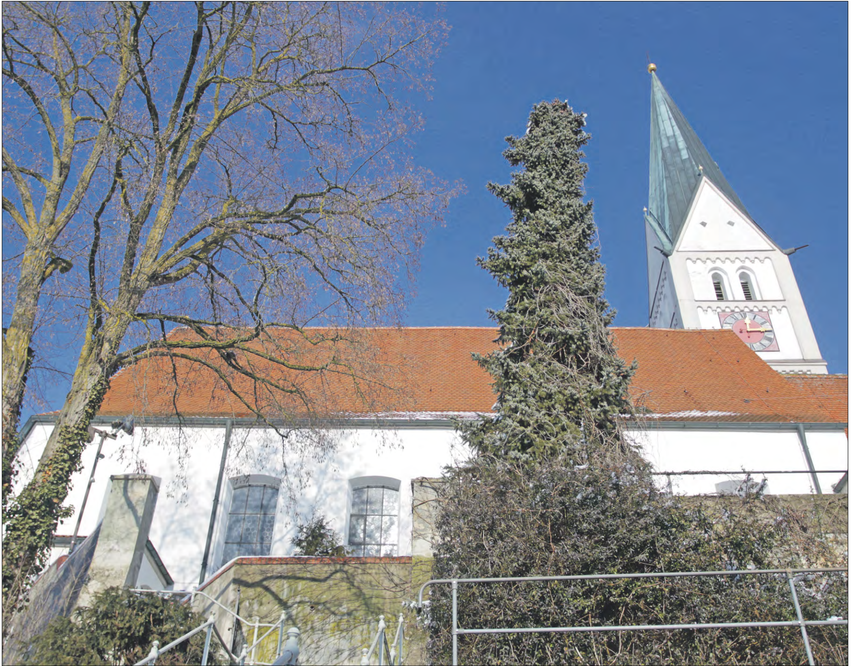
▲ Die Pfarrkirche St. Martin in Dasing wurde 1352 erstmals urkundlich erwähnt. Die Fundamente des Turms sind noch romanisch, der Rest des Turms und der Chor wurden um 1360 erbaut und um 1515 verändert. Das Langhaus, laut dendrochronologischer Datierung um 1690/95 errichtet, wurde 1756 barockisiert und 1938 nach Westen um zwei Achsen verlängert. Seit 1678 besteht eine Rosenkranzbruderschaft, die die Ausgestaltung der Kirche maßgeblich bestimmte. Foto: Zoepf
