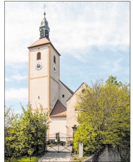
▲ Die Kuratiekirche St. Michael in Ehenfeld wurde mehrmals umgebaut.
