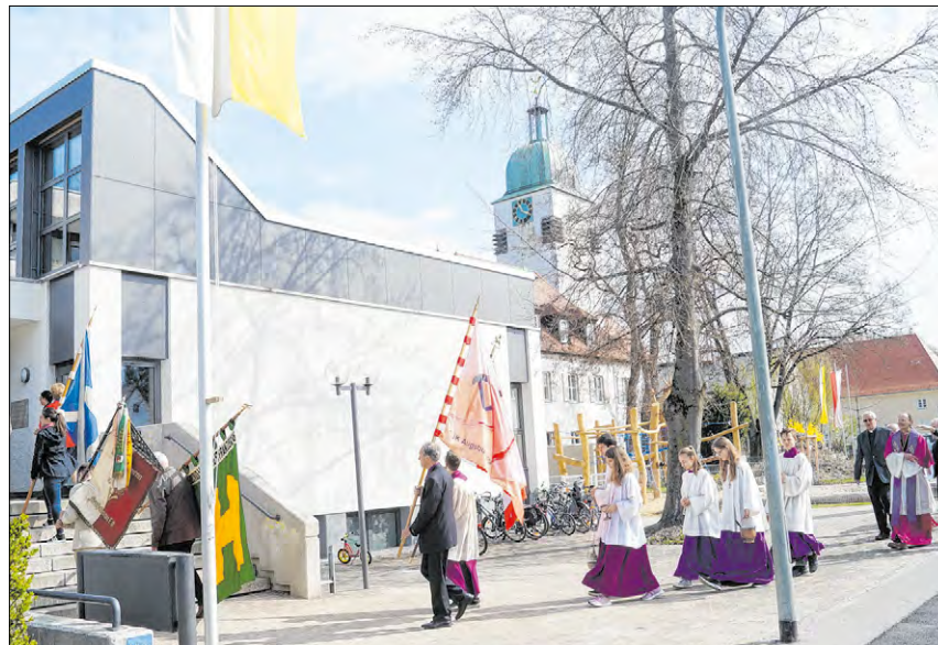
▲ Eines der Projekte, das die Diözese finanziert hat, ist das Begegnungszentrum St. Franziskus in der Augsburgener Firnhaberau. Siehe dazu auch den Bericht auf Seite 19 der Katholischen Sonntagszeitung.
