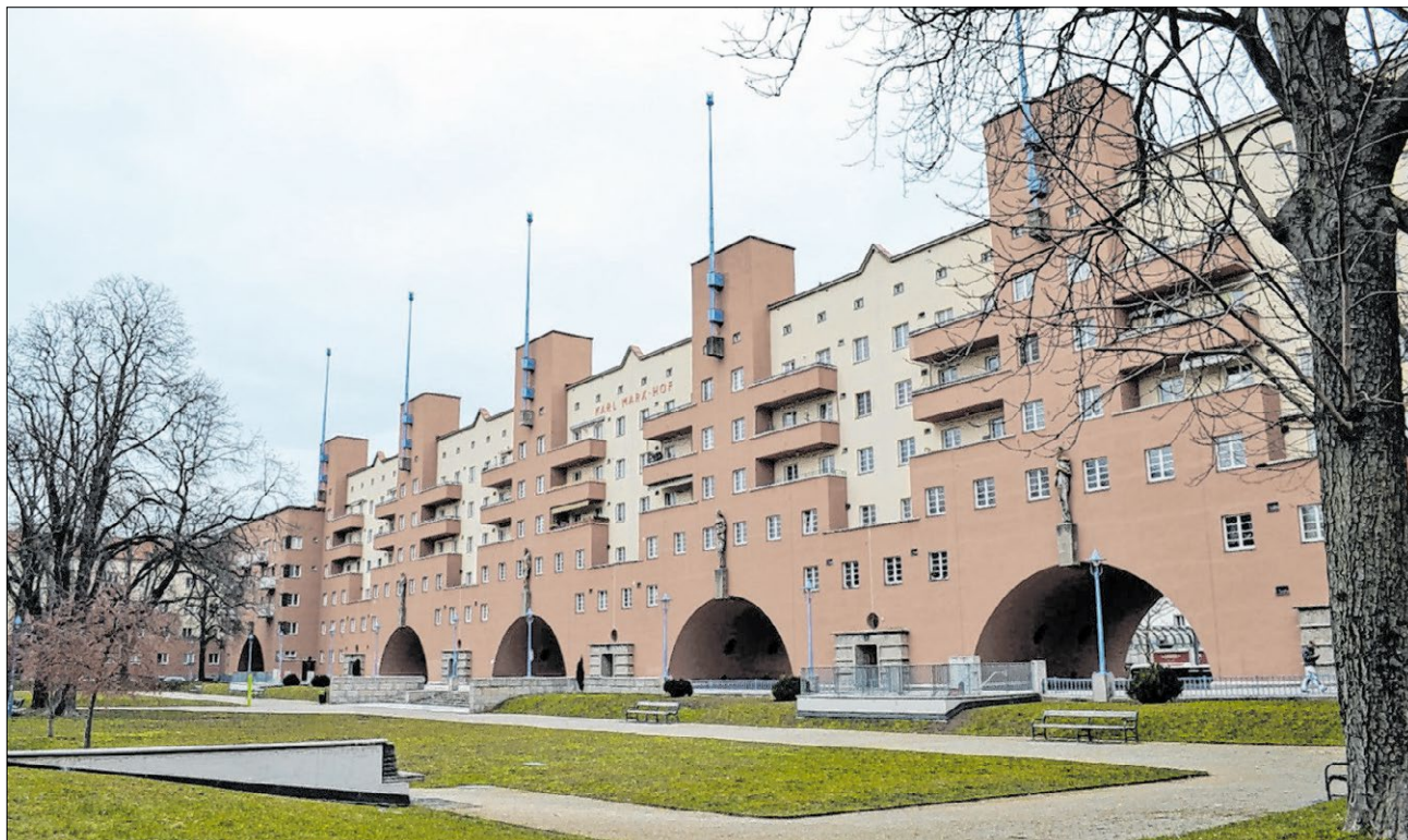
▲ Denkmal des Roten Wien: der zentrale Trakt des 1,2 Kilometer langen Karl-Marx-Hofes. Zwischen den Häusern liegen die gewaltigen Grün- und Spielanlagen. Fotos: Traub
