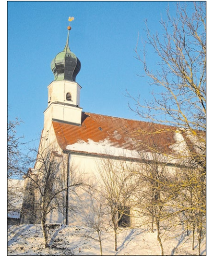
▲ Die kleine Kirche Mariä Himmelfahrt in Frauenwahl scheint im Mauerwerk des Langhauses romanisch zu sein. Foto: Mohr
