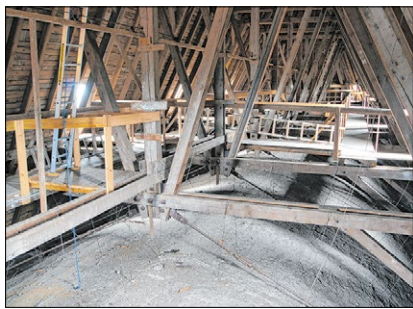
▲ Rabitzgewölbe der Pfarrkirche Heilige Familie in Bad Griesbach (1913).
